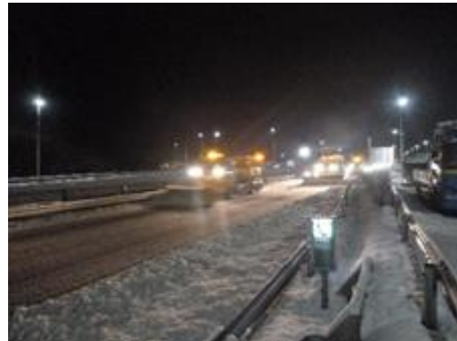
●除融雪作業状況
