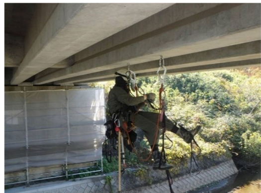
令和3年度点検 中の田橋（Dランプ）点検状況
