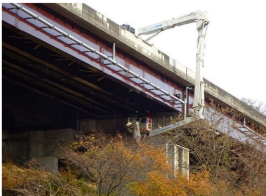
令和3年度点検 天神大橋（上り）点検状況
