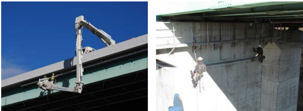
[定期点検実施状況]
