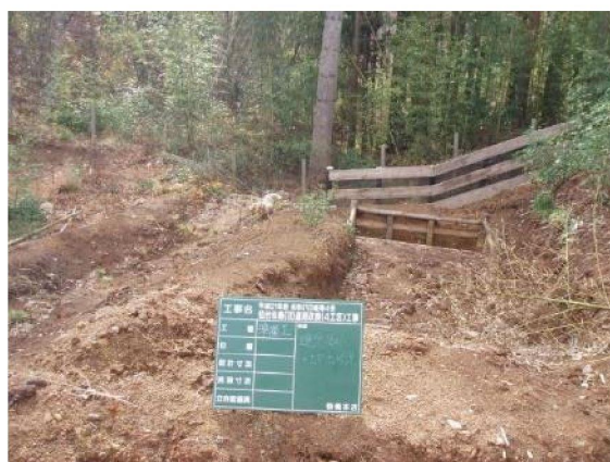
図 6-15 仮沈砂池の設置例
